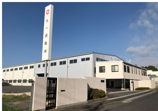
増設倉庫棟および新事務所棟 外観
