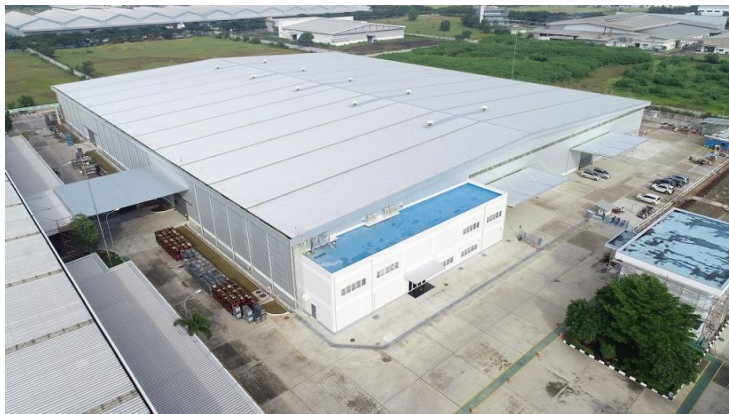
ジャカルタ東部 チカラン工場
