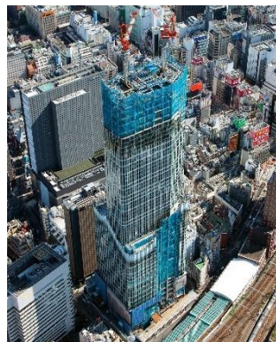
工事進捗状況
