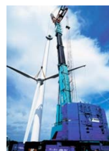
陸上で風車のブレード据付を行うAT
