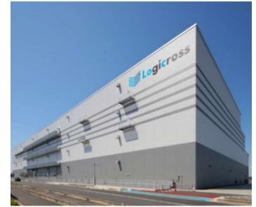
▲ロジクロス春日部 竣工写真
