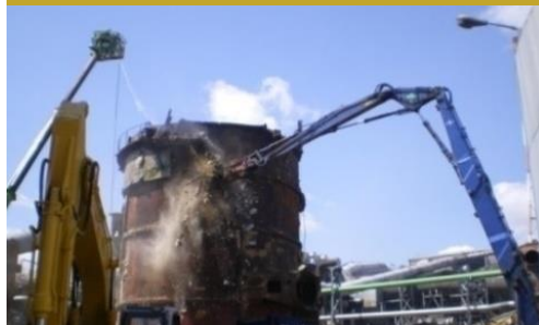
プラント 重機解体
