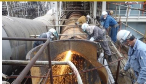
プラント ガス解体
