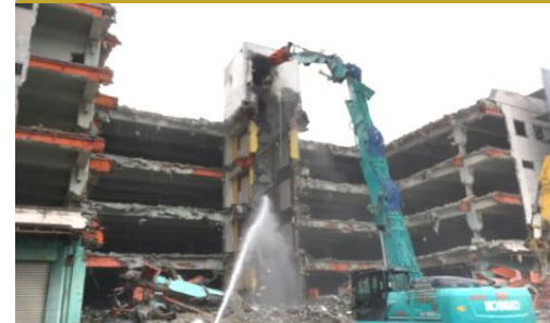
鉄筋コンクリート造解体
