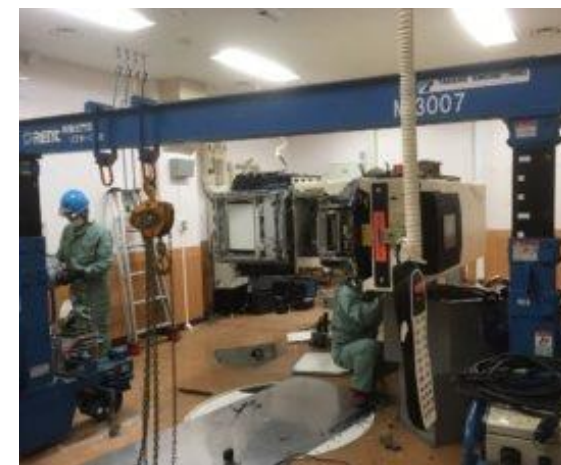
【屋内での解体作業状況】
