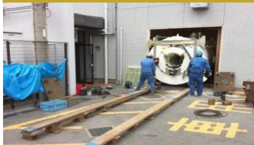
壁面切断・MRI撤去
