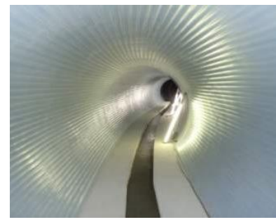
パルテム・フローリング工法 (管路更生工法)
