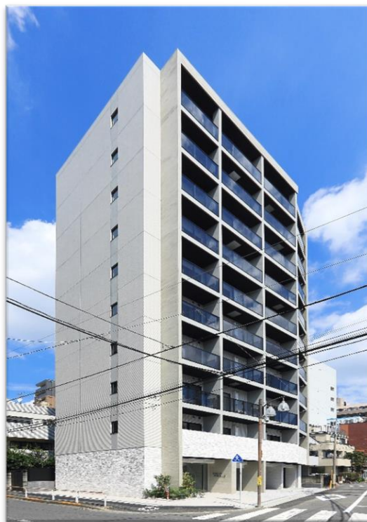
▶ 板橋Ⅴプロジェクト
