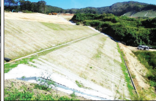
残土仮置場の造成工事
