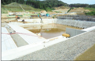
防災調整池付近の造成工事
