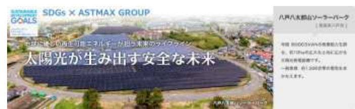
【太陽光発電所：八戸八太郎山ソーラーパーク】
