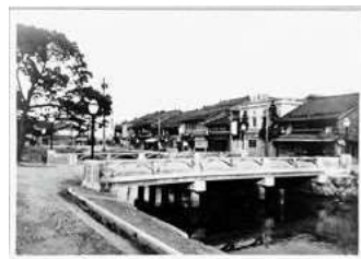
長生橋（石川県七尾市）
