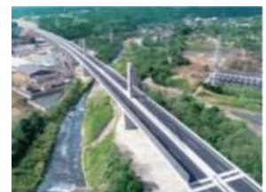
新名神高速道路孤野第二高架橋他3橋（PC上部工）工事
