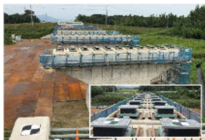
UVAを活用した測量事例（支承位置測量・橋面出来高測量）
