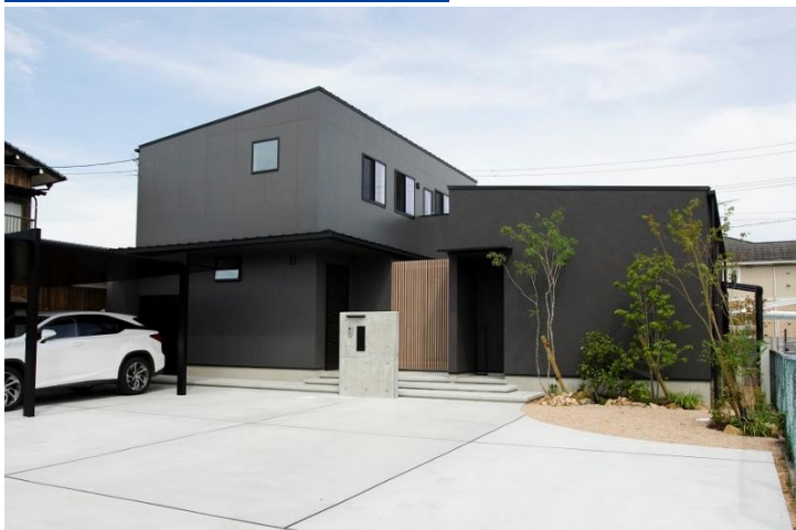
新築工事（戸建て住宅）
