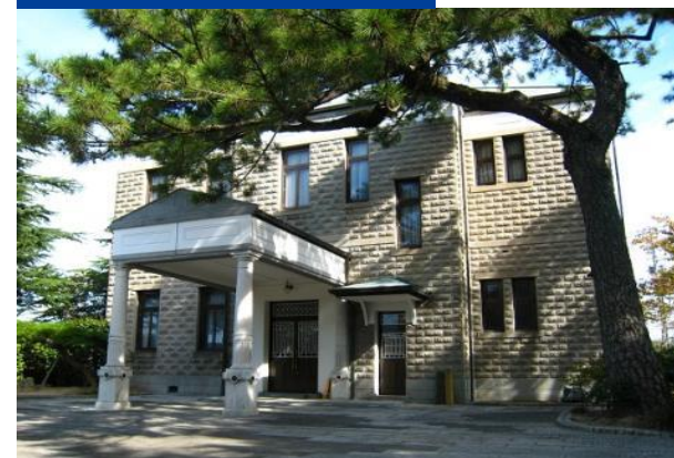
施工後 国有文化財
