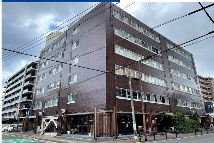
施工後 マンション
