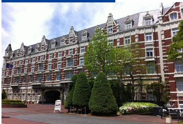
施工後 テーマパーク
