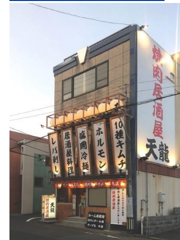
店舗新装工事
