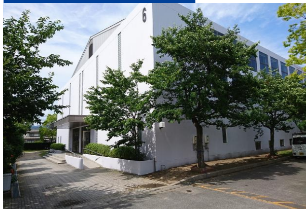
施工後 学校施設
