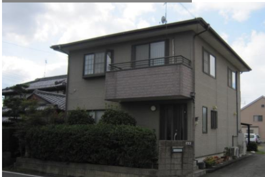
施工前 戸建て住宅
