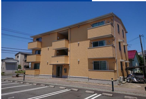
施工後 アパート
