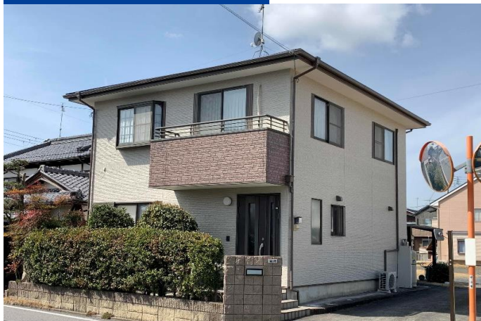
施工後 戸建て住宅
