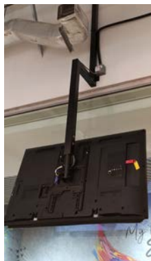
店舗天井の補強
