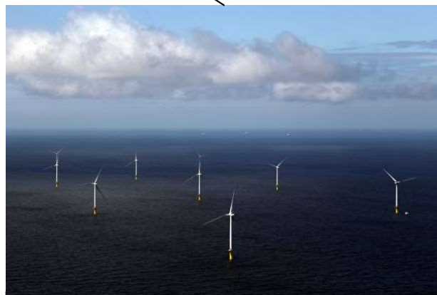
ルフタダウネン洋上風力発電所
