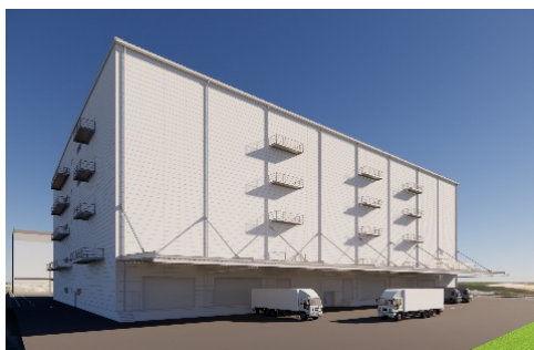
【IIF 四日市ロジスティクスセンター（新築棟）】
