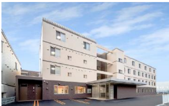
要介護者向け介護事業施設 北海道札幌市 （サービス付き高齢者住宅）
