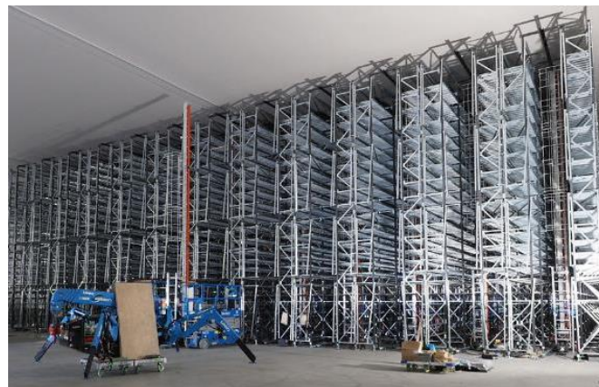
ケース品自動倉庫(階高 9.9m)
