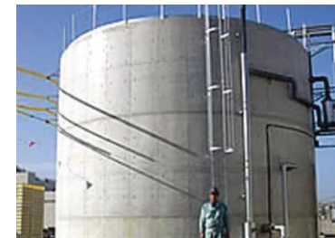
バイオマス燃料製造設備
