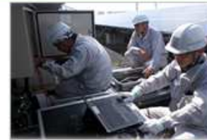
発電所の検査サービス
