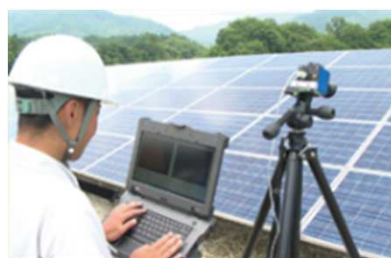
発電所の検査サービス
