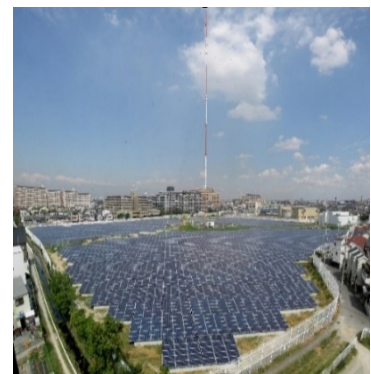
高石ラジオ送信所の太陽光パネル
