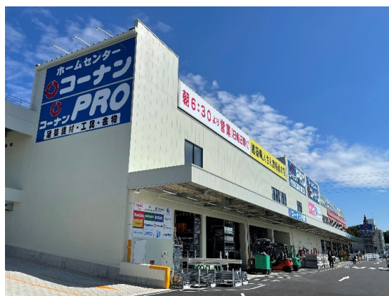
■国道171号向日町店 (PRO+HC 一体型店舗)
