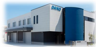
[広島営業所 外観写真]
