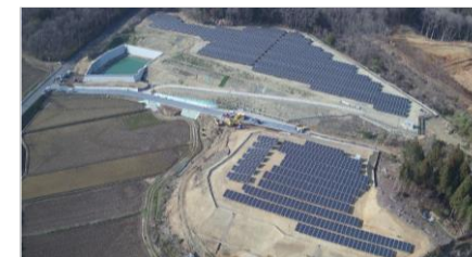
S-28 茨城常陸大宮太陽光発電所
