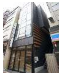
東京 レガリス新橋
