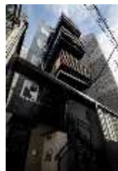
セットアップオフィス THEOTEX BUILDING
