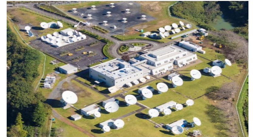
副局：茨城ネットワーク管制センター（茨城県常陸大宮市）
