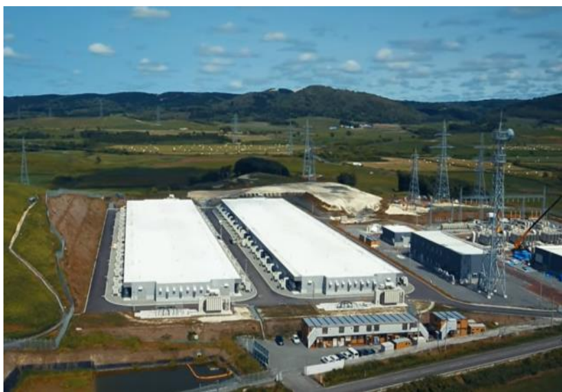
*1 蓄電池システム外観(全景)
