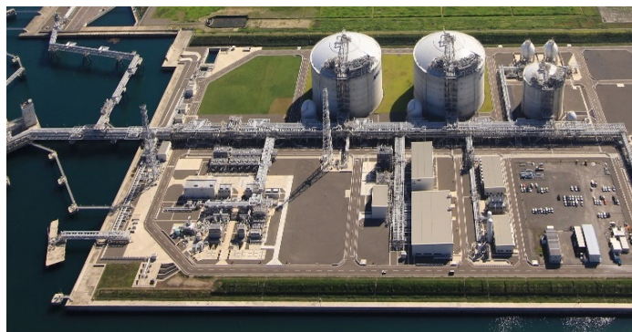
直江津LNG基地
