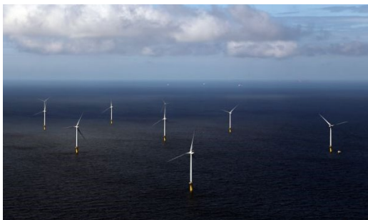
ルフトダウネン洋上風力発電所
