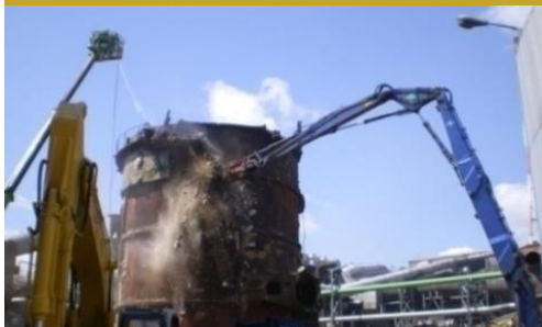
プラント 重機解体
