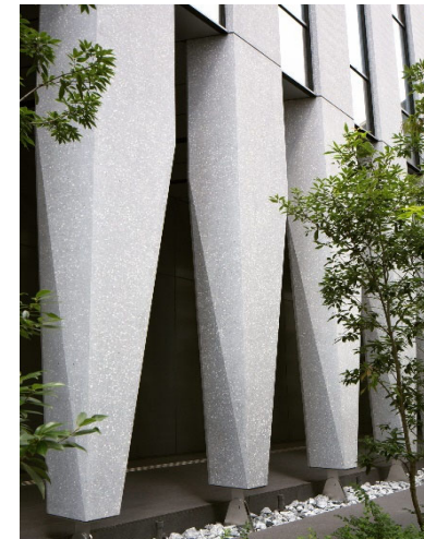
イシダ東京第一ビル (東京都板橋区)
