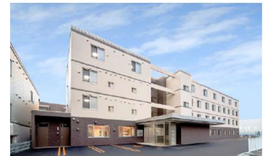
要介護者向け介護事業施設 北海道札幌市 (サービス付き高齢者住宅)
