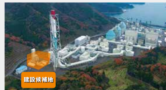
パイロットスケール試験設備の設置イメージ
