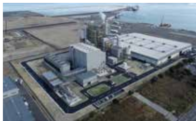
【バイオマス】かんだバイオマス発電所
