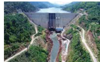
【水力】ナムニアップ1発電所
