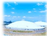
ガス製造・供給
