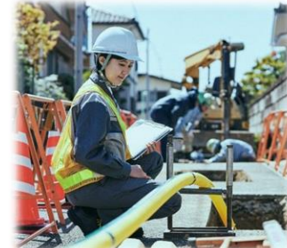
地震に強いポリエチレン管への入替等による導管耐震化率向上
