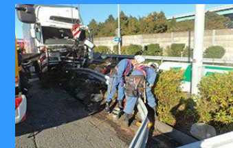
事故復旧工事
