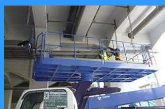
床版補修工事
