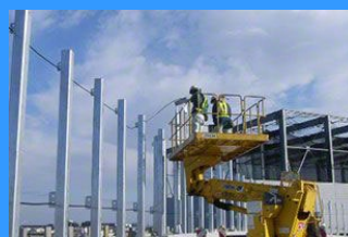
フェンス設置工事
