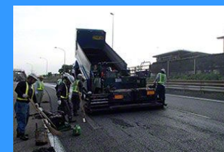
舗装補修工事
