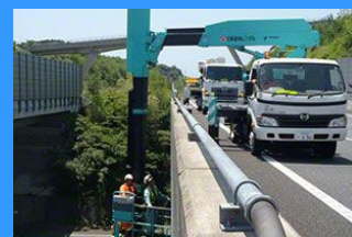
橋梁点検工事
