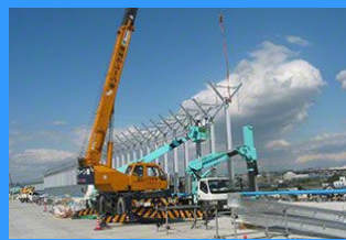
遮音壁設置工事
