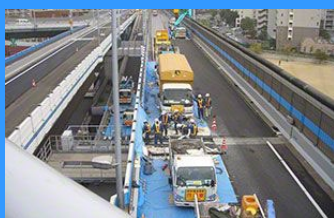
伸縮継手補修工事
