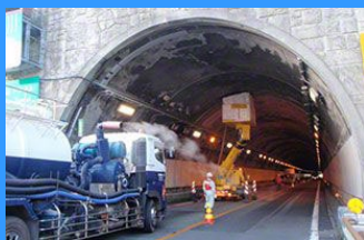
トンネル補修工事
