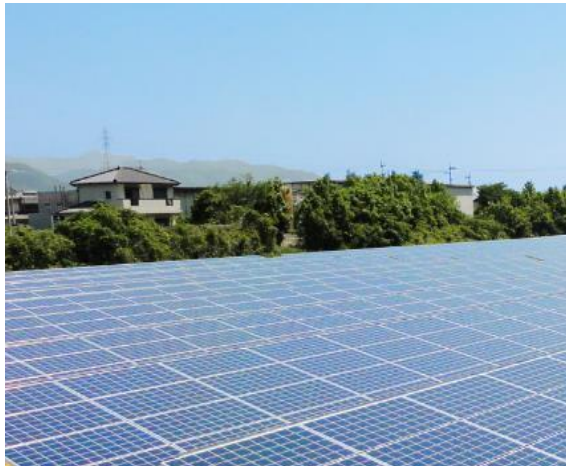
コンパクトソーラー発電所
