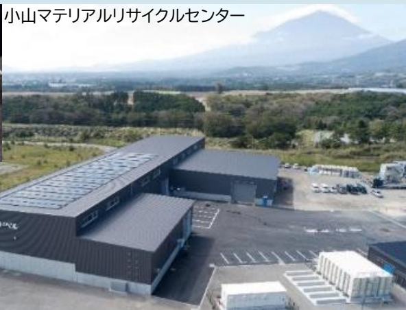
小山マテリアルリサイクルセンター
