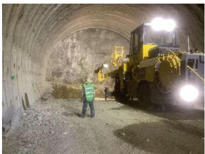
第四南巨摩トンネル 東工区 本坑の掘削
