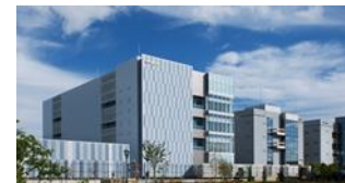
岡山データセンター
