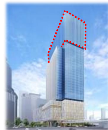
梅田3丁目計画(仮称) 上層30～38階が客室フロア
