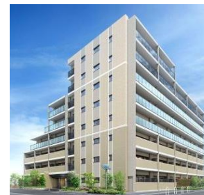
シャルマンフジ 三国ヶ丘 けやき通り 8F 49邸 2022年3月25日に完成引渡
