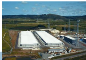
蓄電池システム全景 (建設中)
