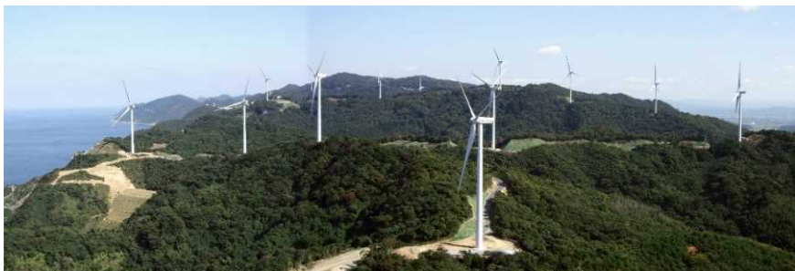
風力発電等、再生可能エネルギー関連工事
