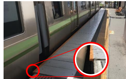
《転落防止ゴムの整備》
