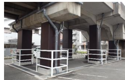
《高架橋耐震補強工事》
