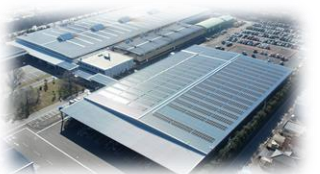
太陽光発電設備(太田ドア工場物流棟)
