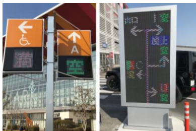
駐車場満空情報を利用者へ表示するためのLEDサインシステムの導入
