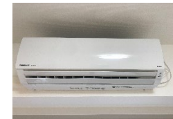
省エネ型エアコン設置 (TKフラッツ渋谷)
