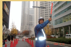
交通誘導警備
