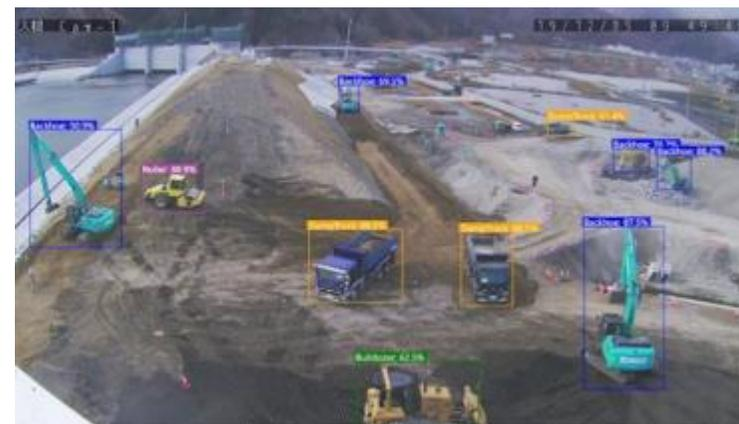
AIによるダンプおよび建機の識別結果
