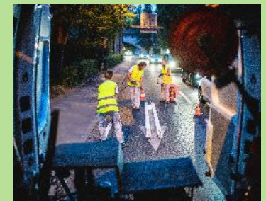
建設・土木業者
