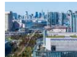
インフラ設備
