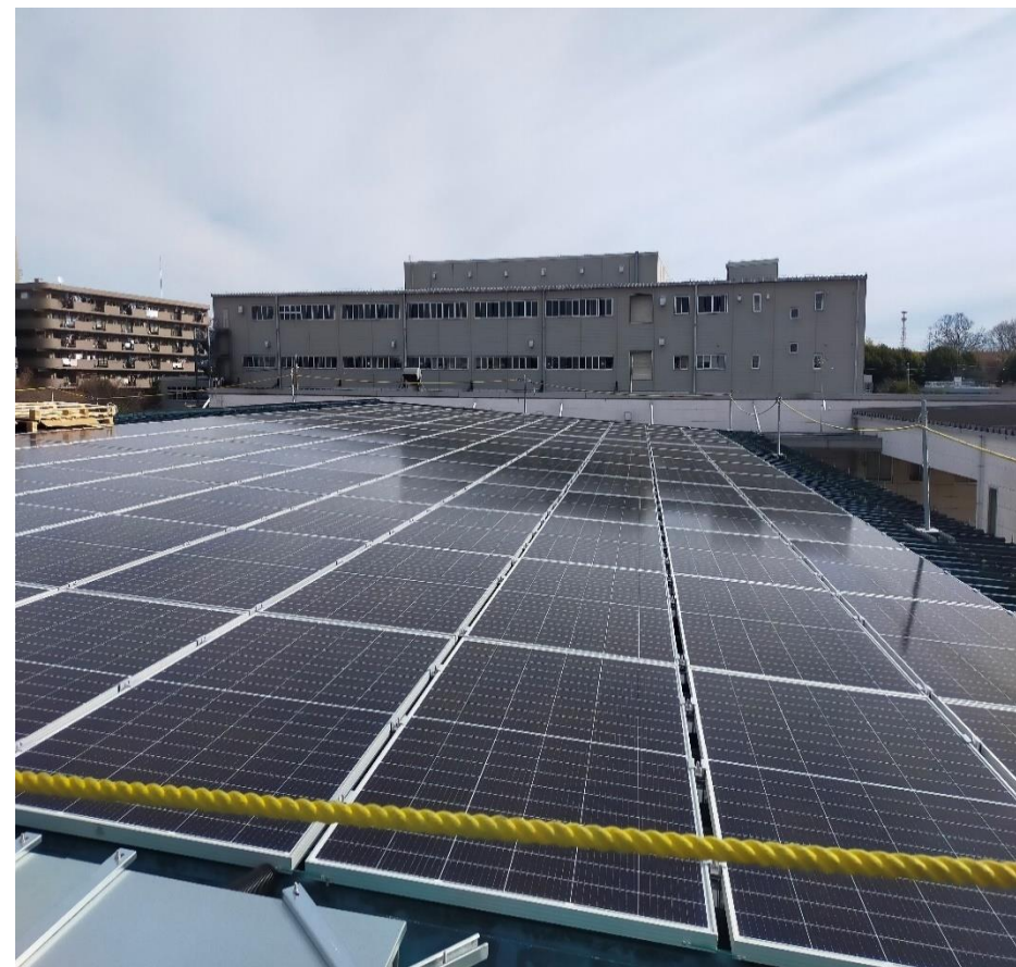
2022年1月関東事業所 太陽光パネル設置の様子
