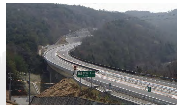
岡山自動車道 岡山JCT～有漢IC間舗装工事
