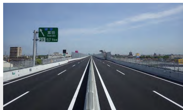
名古屋第二環状自動車道 名古屋西JCT～飛島JCT間舗装工事
