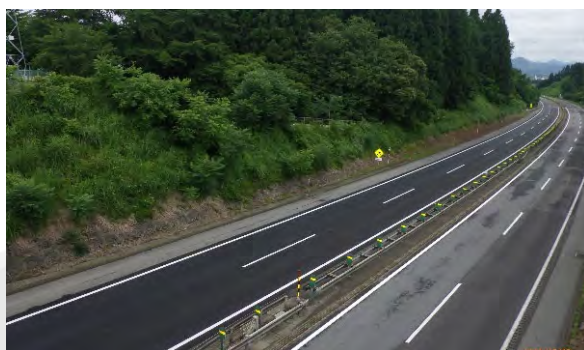
東北自動車道 十和田管内舗装補修工事
